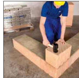
Mauerstein wie gewohnt ausrichten. Fertig!
