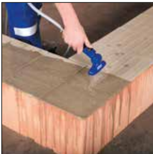
maxit Mörtelpads befeuchten
