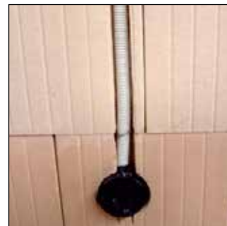
Einlegen der Elektroinstallation in die Schlitzte.
