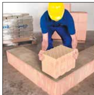
Mauerstein vollflächig auflegen
