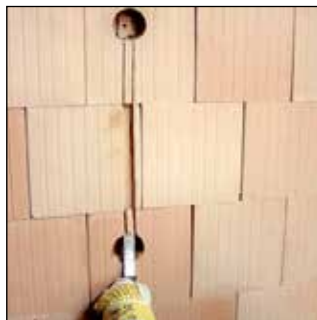
Vorgesägte Schlitzte mit Hammer und Meißel freischlagen.
