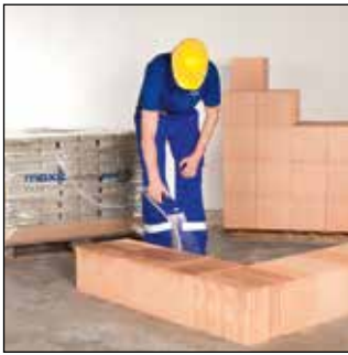
Mauersteine befeuchten
