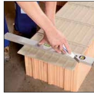
maxit mörtelpads bei Bedarf zuschneiden
