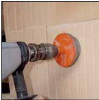
Elektrodose anzeichnen und mit handelsüblicher Bohrmaschine und Diamant-Trocken-Bohrkrone Kernbohrung vornehmen.
