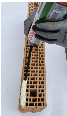
4. Breng de lijmrillen aan op schone en stofvrije blokken (2 horizontale rillen per steen op de wandrijen grenzend aan de buitenzijde)
