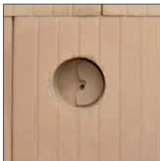
Eventuele baksteenresten en boorstof verwijderen – de perfecte opening voor een inbouwdoos is klaar!
