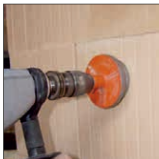
De opening voor de inbouwdoos markeren en met een in de handel gebruikelijke boormachine en een diamantboorkroon uitboren.
