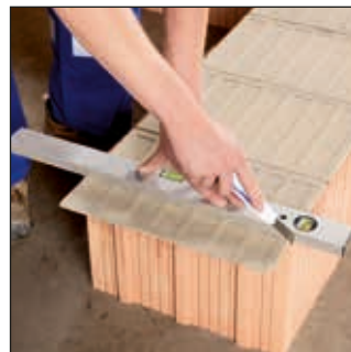
Maxit dunbedmortelpad indien nodig afsnijden
