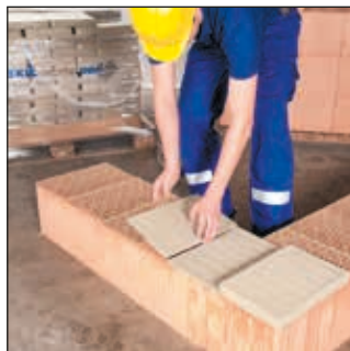
Maxit dunbedmortelpad erop leggen
