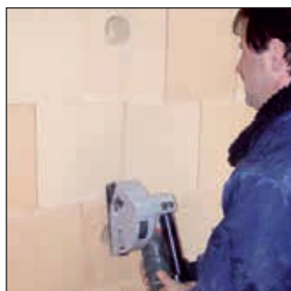
Aanbrengen van sleuven in de bakstenen met de sleuvenfrees.
