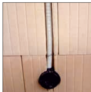
Aanbrengen van de elektriciteitsinstallatie in de sleuf.
